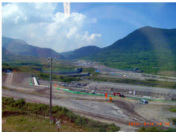
水無川には透過型のえん堤が設置され、 今でも工事中である。
