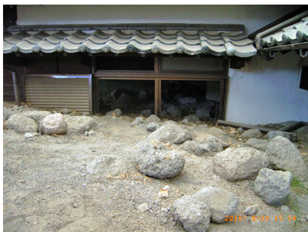
左：家屋の中の様子。 家の内部は、粒径 0.5m 程度の 岩石と土砂で満たされている。
